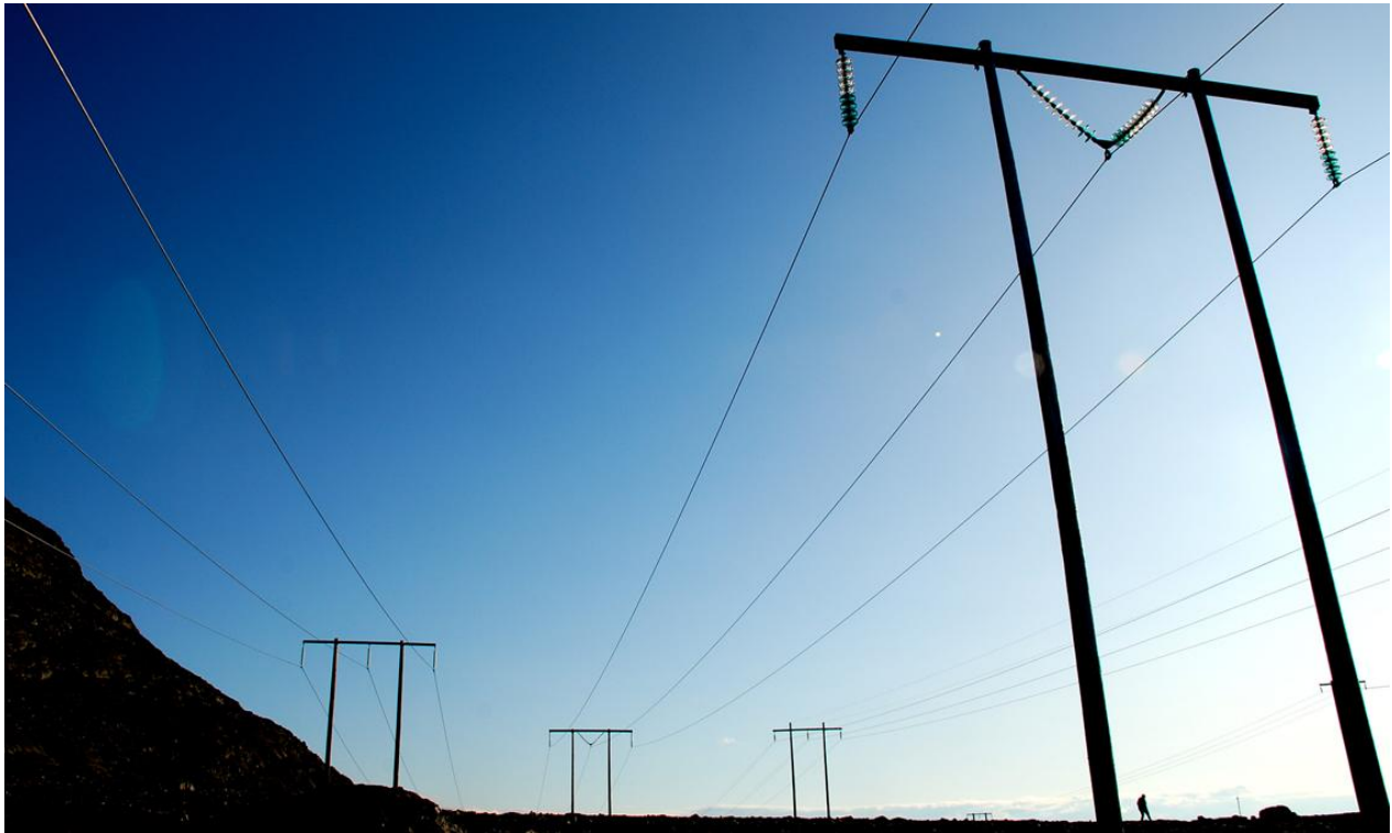
FIGUR 12: HÖGSPÄNNINGSLEDNINGAR I NORRA NORGE
