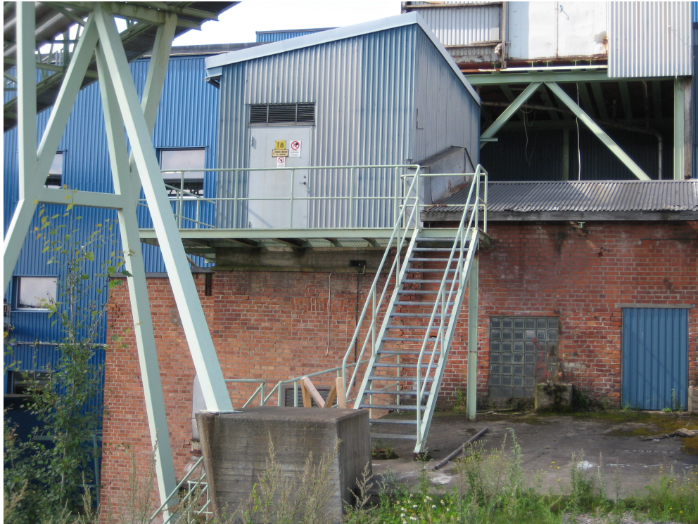
Figur 20. Lågspänningsställverk med transformator T8.
