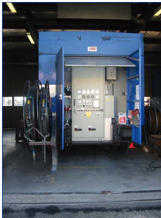
Figur 14: Två olika typer av reservkraftaggregat som används inom koncessionsområdet.
