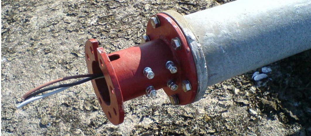
Figur 3.1 Flänsen monterad på tornet.
