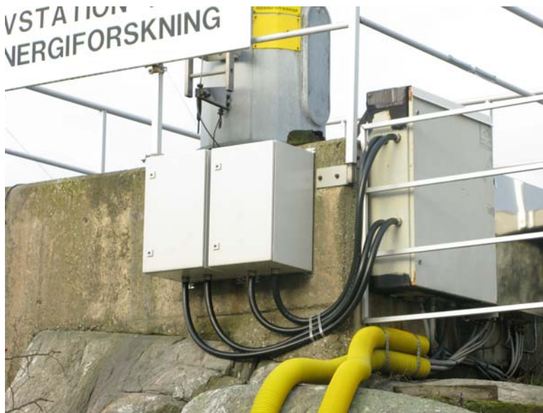
Fig. 2.7: Vindkraftverkets fundament med likriktarskåpet till höger och de två skåpen med seriekompenseringskondensatorerna till vänster.
