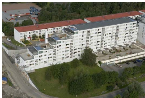
Figur X. Terrasshus i Gårdsten. www.samhallsbyggardagen.se/s25095
