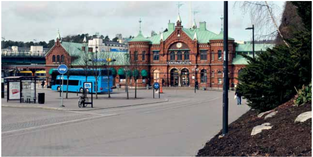
Figur 6.1. Järnvägs- och busstation i Borås.
