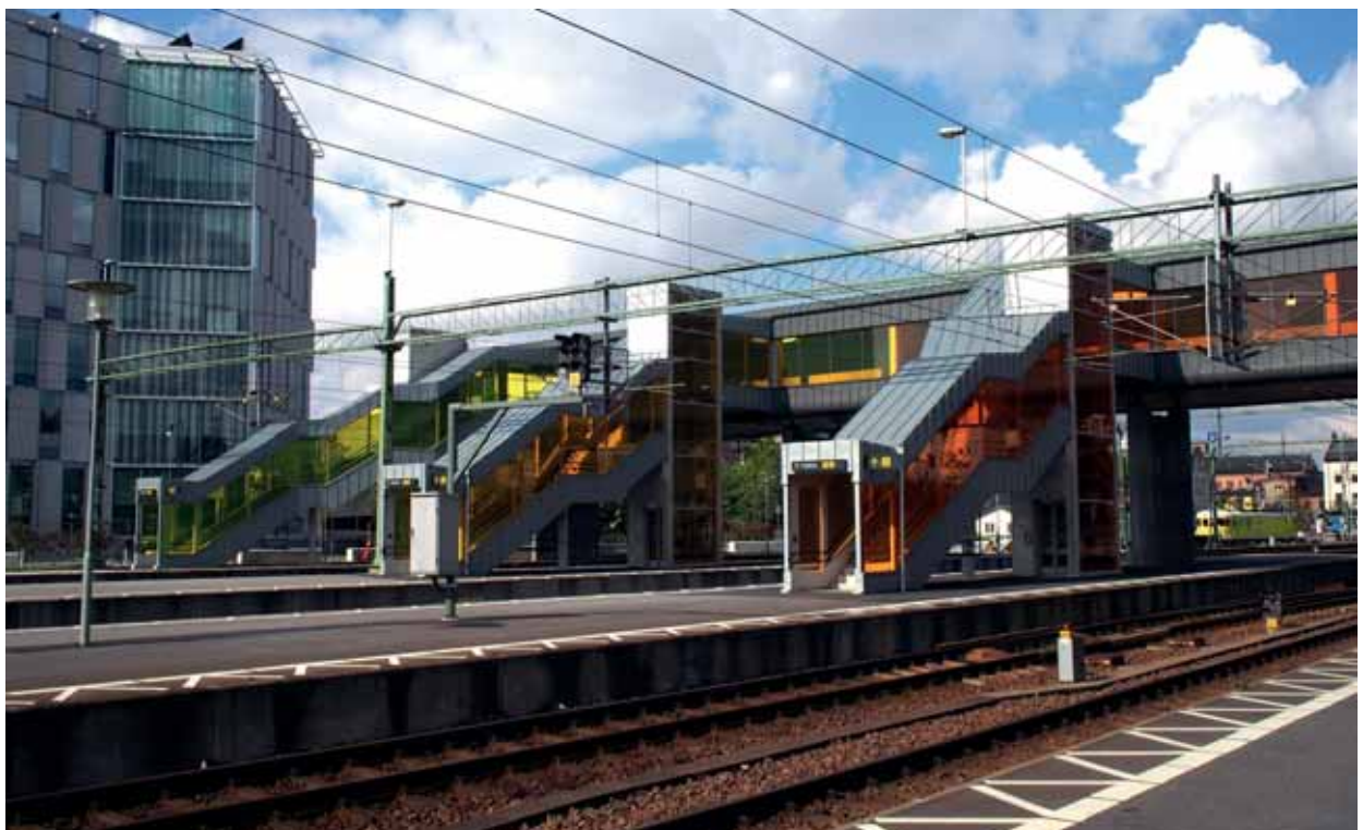
Figur 6.3. Nybyggnation och övergång vid stationen i Lund.
