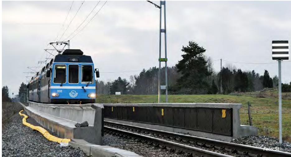
SPÅRNÄRA BULLERSKÄRMAR längs Roslagsbanan. De låga skärmarna får avsevärt mindre visuell påverkan än konventionella, höga skärmar.
